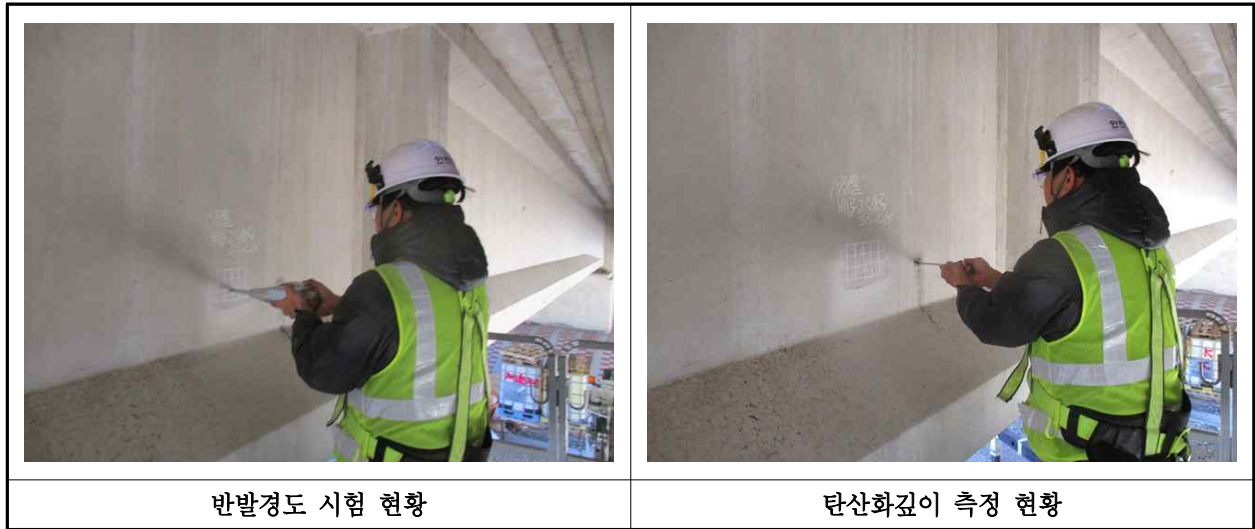
【사진 21.4.1】 콘크리트 내구성조사 현황
