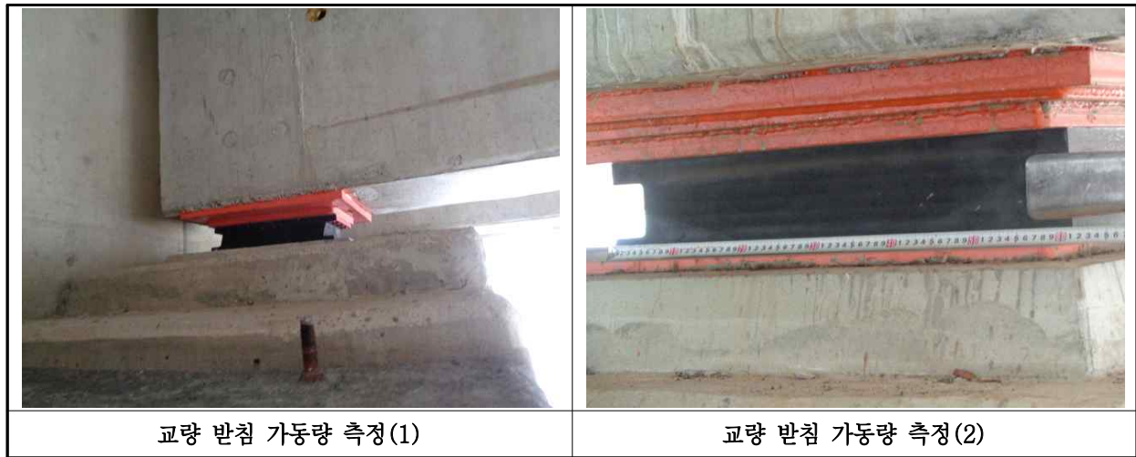
【사진 21.3.38】 교량받침 이동량 측정
