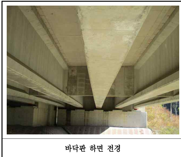
【사진 21.3.2】바닥판하면 전경
