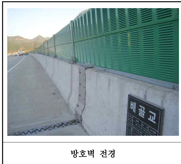
【사진 21.3.46】 방호벽 및 중앙분리대 전경
