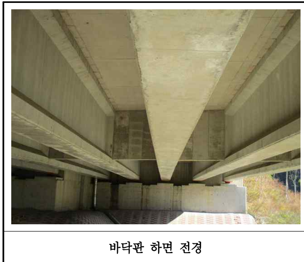
【사진 21.3.25】 바닥판하면 전경
