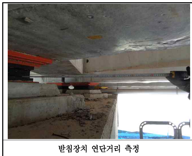
【사진 21.3.14】 교량받침장치 연단거리측정
