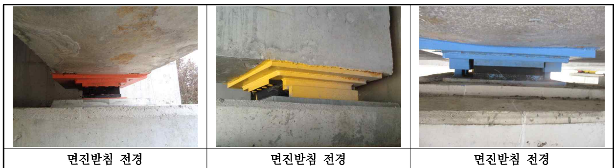
【사진 21.3.12】 교량받침 전경
