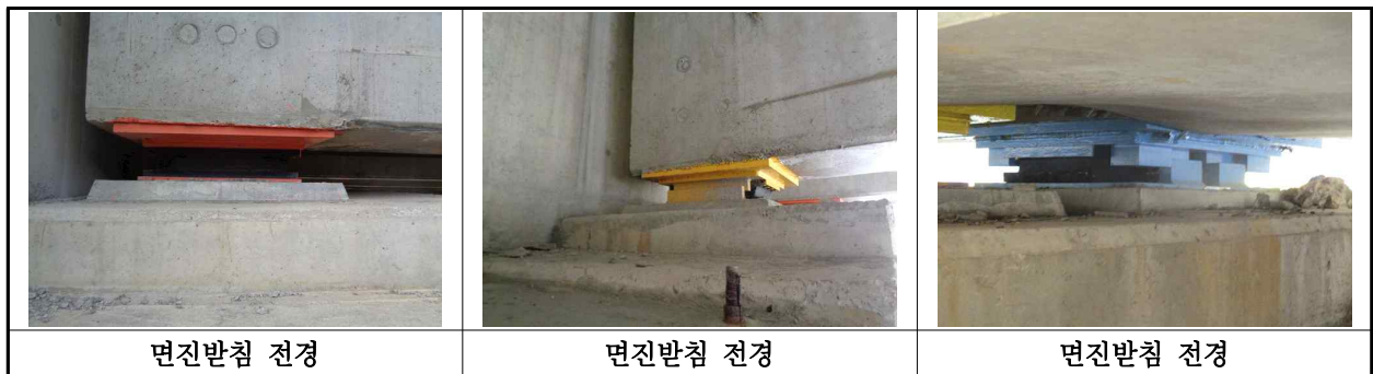
【사진 21.3.35】 교량반침 전경
