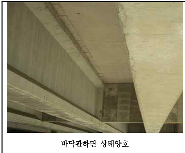
【사진 21.3.26】 바닥판하면 손상현황
