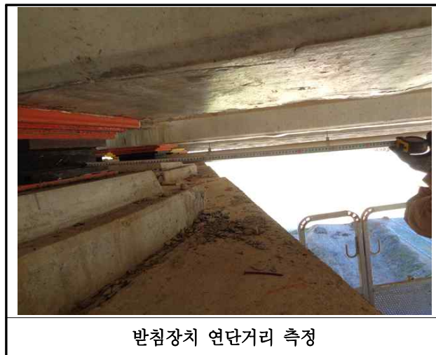
【사진 21.3.37】 교량받침장치 연단거리측정
