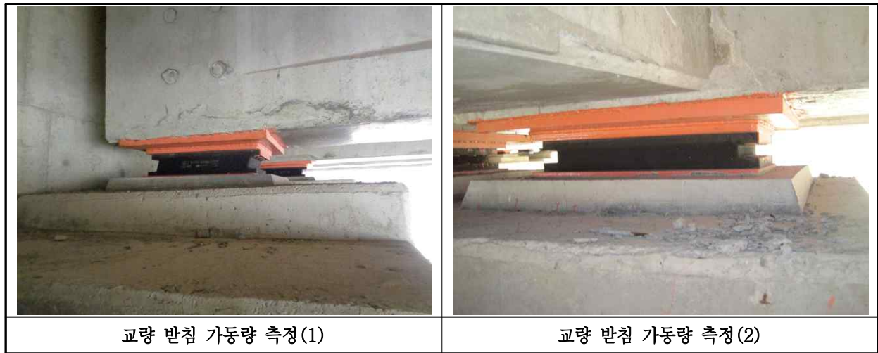
【사진 21.3.15】 교량받침 이동량 측정
