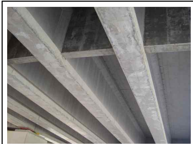
거더 내측 전경
